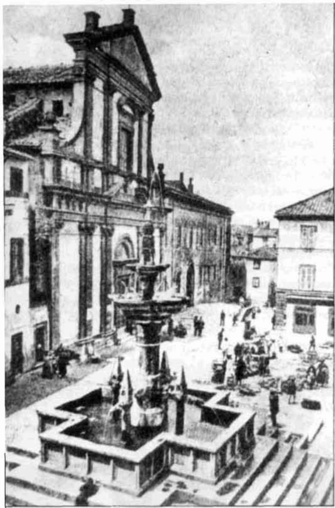
La facciata della chiesa e del convento degli Scalzi, sulla piazza Fontana Grande, nei primi anni del '900. Dopo l'esproprio, nell'edificio trovarono sede gli uffici del Tribunale, mentre la chiesa divenne l'aula della Corte d'Assise, ed ospitò processi importanti, come quelli alla banda Cuocolo, e, più recentemente, alla banda Giuliano.
