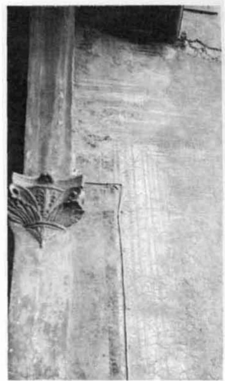
Fig. 13 - Cortile del palazzo. Fig. 14 - Resti degli affreschi che ricoprivano la parete chiusa sopra il portico.
