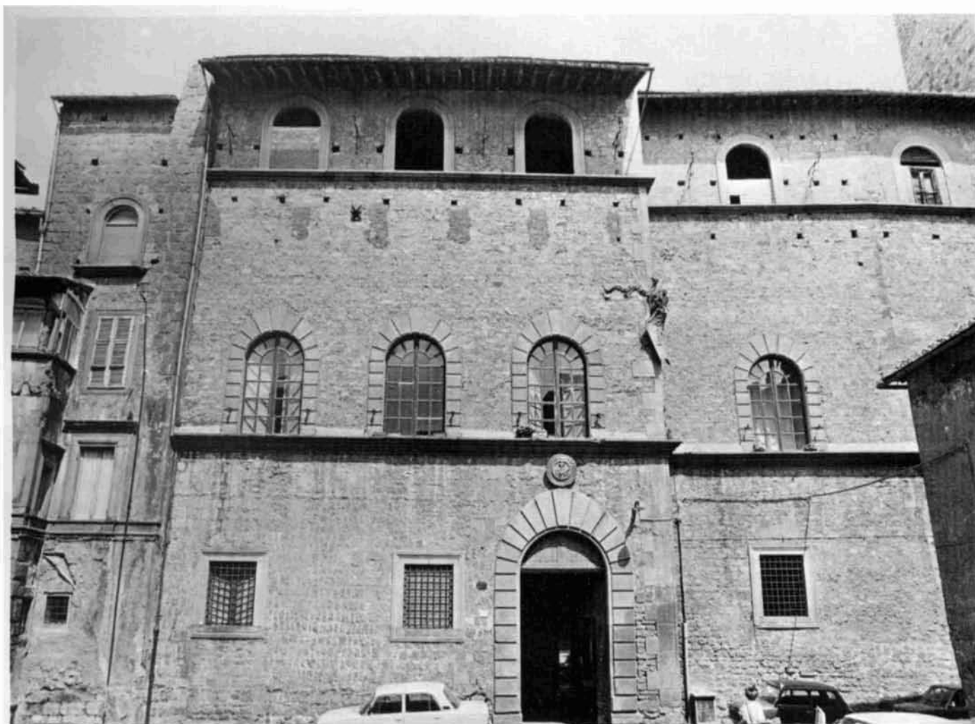
Fig. 1 - Prospetto principale sulla via Chigi.
