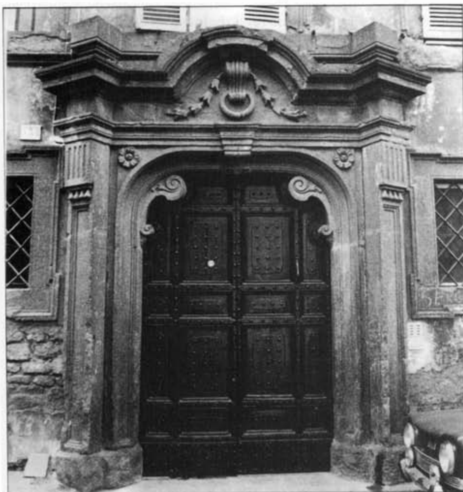
Portale sito in Via Prada n. 3
