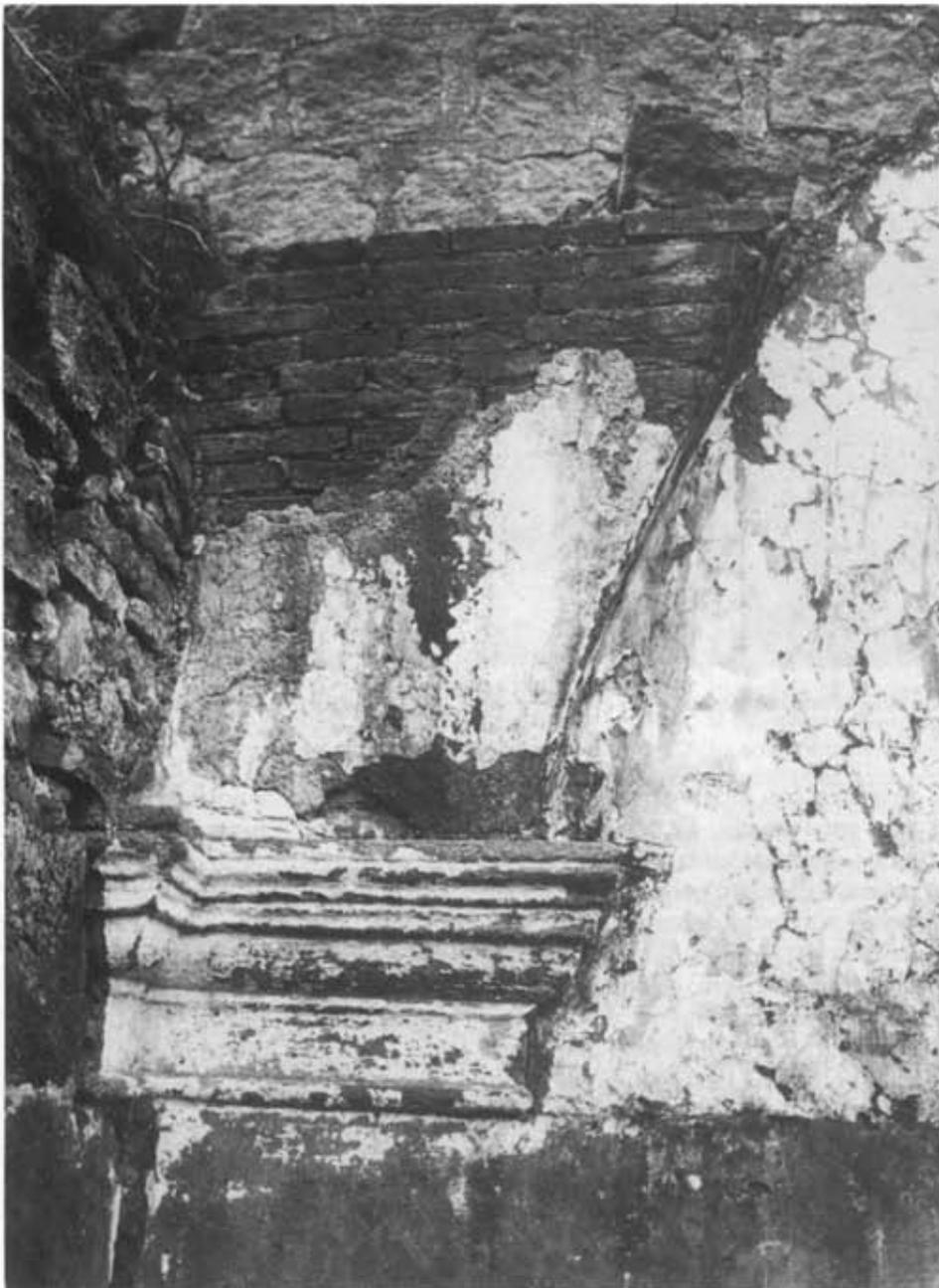
Fig. 12-13 Particolare di uno dei quattro peducci d'angolo. In basso, colonna chiusa nel muro della galeotta con le imposte a mattoni di un arco e delle volte.
