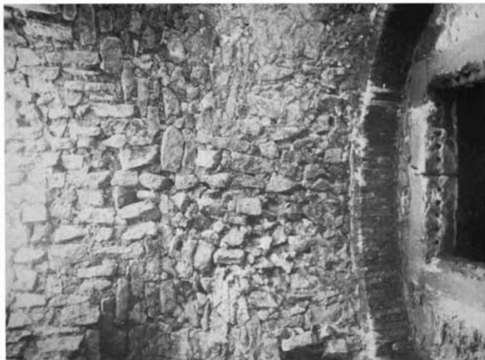
Fig. 9-10 Particolare della disposizione del pietrame in una delle volte con uno degli archi a mattoni che divide la navata centrale dalle laterali. In basso un capitello di colonna con l'imposta della volta a mattoni.
