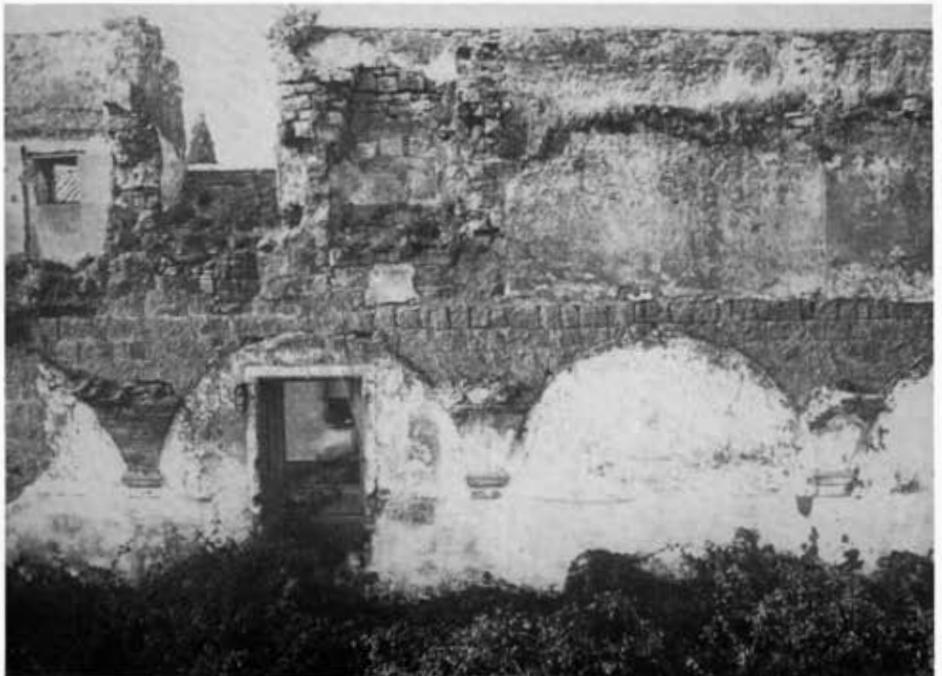
Fig. 8 Antico muro urbano con i peducci e gli attacchi delle volte a mattoni.
