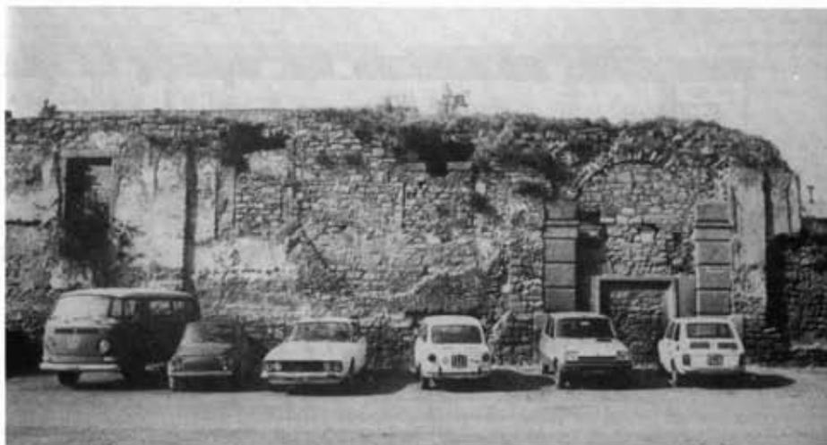
Fig. 6-7 Attuale prospetto esterno e l'interno col muro di tamponamento che delimita la galeotta; sopra le colonne vi sono le tracce dei pilastri quadrati del sovrastante fienile.
