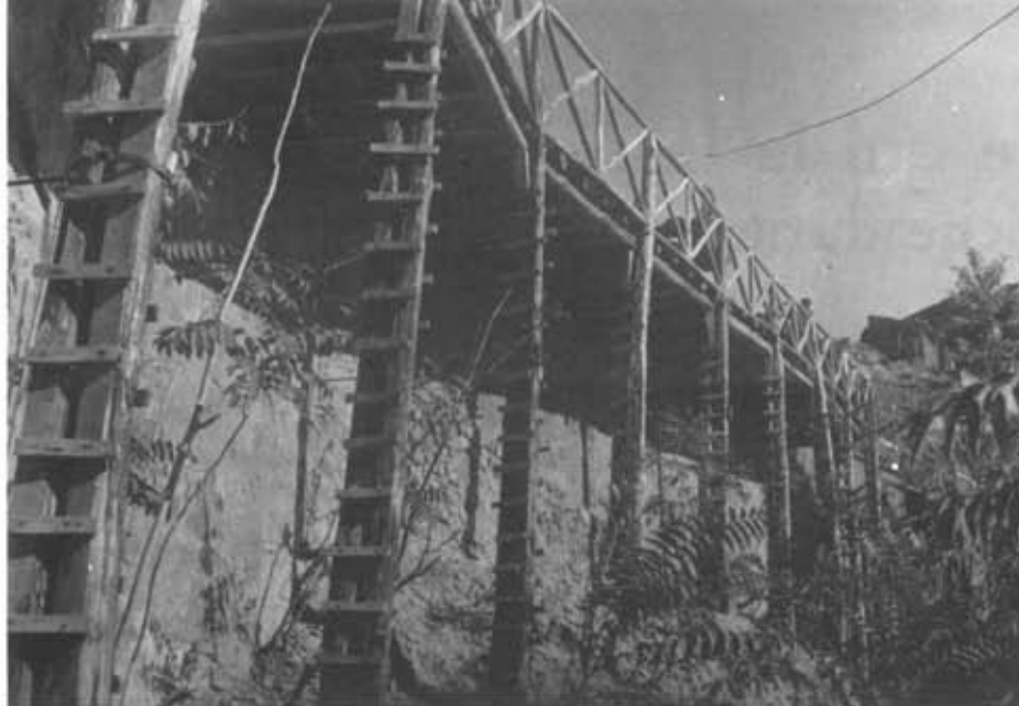
Vista dal basso delle precarie strutture lignee messe in opera nel 1958 dopo l'ennesimo crollo del ponte in muratura.
